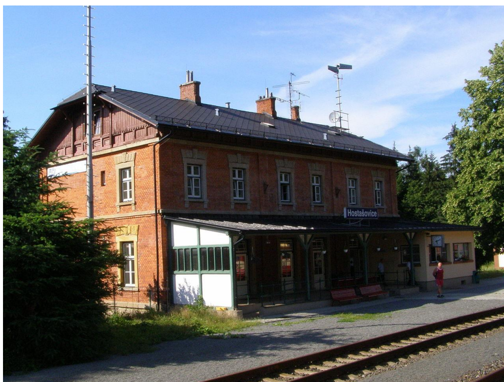
Železniční stanice Hostašovice (foto cs.wikipedia.org).
