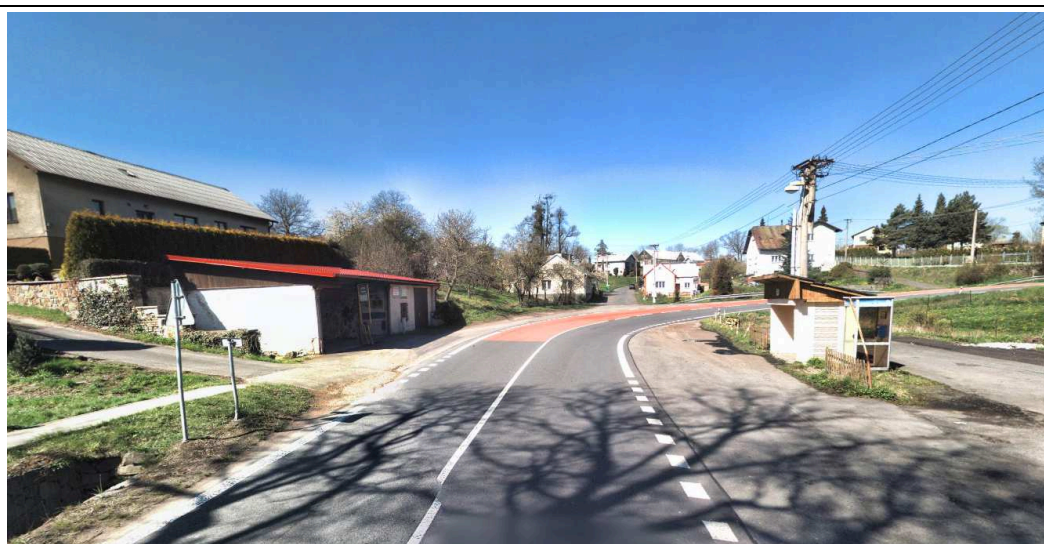
Vlevo autobusová zastávka - plocha Z10 DS, vpravo autobusová zastávka Z9 DS.
