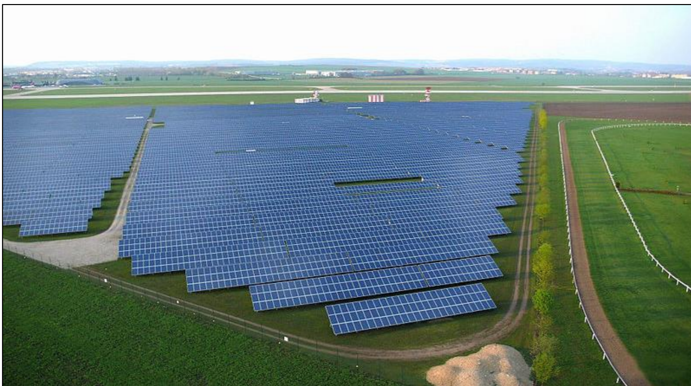
Fotografie 5: Příklad FVE jako samostatná stavba na terénu: Solární park Brno-Tuřany (Autor: Petr Opletal)
