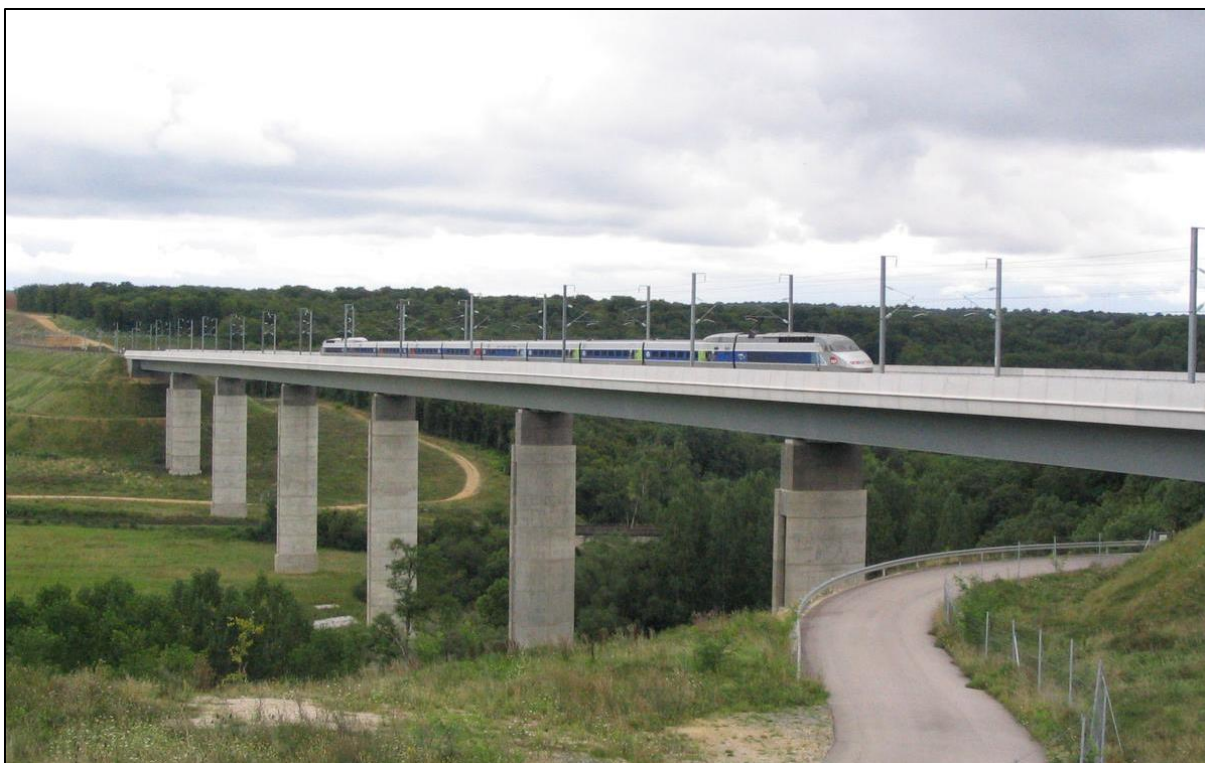
Obrázek 11: Ukázka vedení VRT po estakádě: Viaduc de Jaulny, Francie (Zdroj: International Database and Gallery of Structures, Structurae.net)
